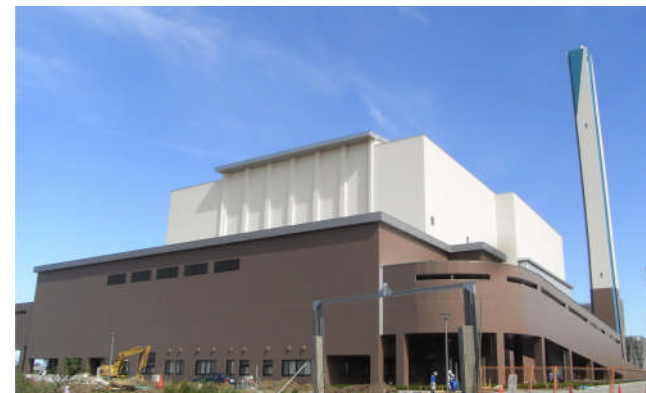
資源化センターの熱改修施設。煙突の高さは90m！
